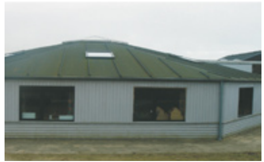
Den nye SFO-tilbygning
